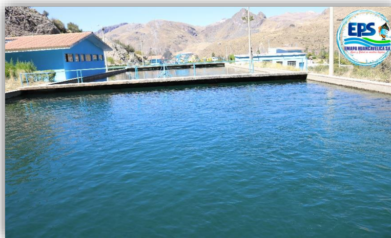
Planta de Tratamiento de Agua Potable Millpo
