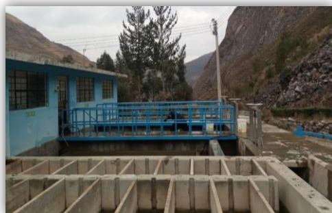
VISTA DESPUÉS DEL MANTENIMIENTO DE LA PTAP ICHU
