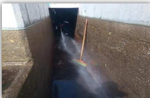
LIMPIEZA DE CÁMARA DE AGUA FILTRADA- PTAP ICHU
