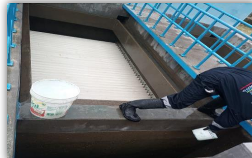
LIMPIEZA Y DESINFECCIÓN DEL CANAL DE DISTRIBUCIÓN DE AGUA FLOCULADA - PTAP ICHU
