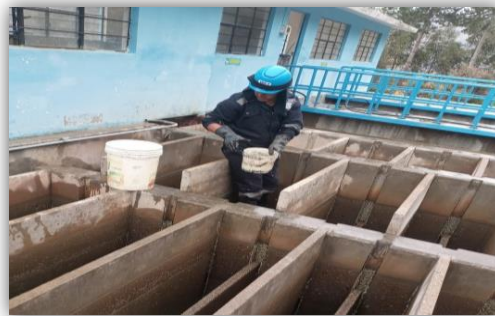
LIMPIEZA DE DECANTADORES - PTAP ICHU
