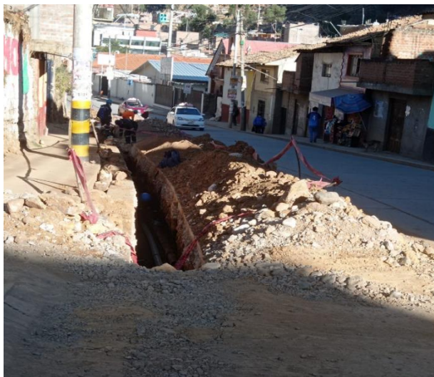
TRABAJO EN EL JIRÓN MANCO CAPAC DISTRITO DE HUANCAVELICA
