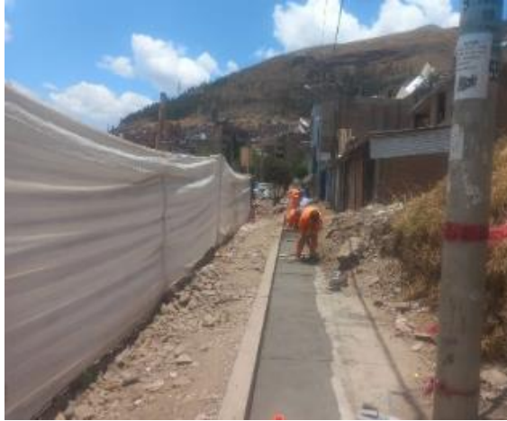
TRABAJO EN EL MALECON SANTA ROSA DEL DISTRITO DE HUANCAVELICA
