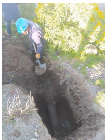
Identificación de las Nuevas redes de agua potable y alcantarillado por parte de la EPS EMAPA HUANCAVELICA obras Ejecutadas por la Empresa
