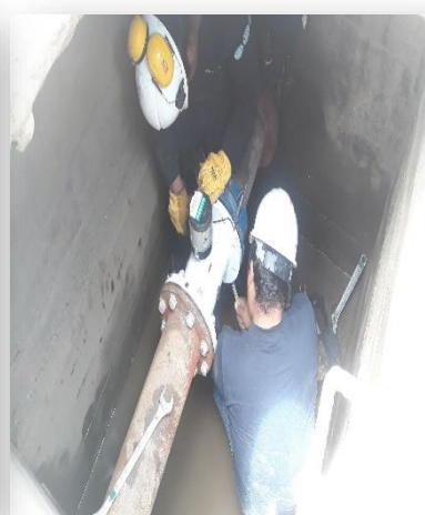
RENOVACION DE 17 MACROMEDIDORES DE 90mm, 110mm, 250mm,315mm EN LOS 10 SECTORES
