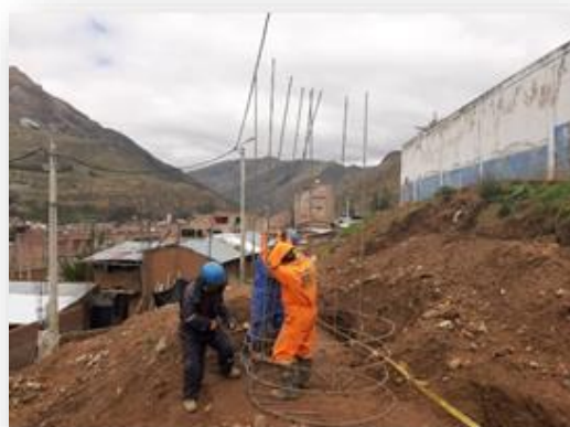
ARMADO DE ACERO PARA BUZÓN D=1.60, H=3m
