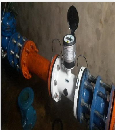
RENOVACION DE 17 MACROMEDIDORES DE 90mm, 110mm, 250mm,315mm EN LOS 10 SECTORES
