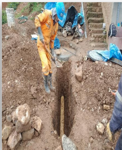
INSTALACIÓN DE REDES DE DESAGUE
