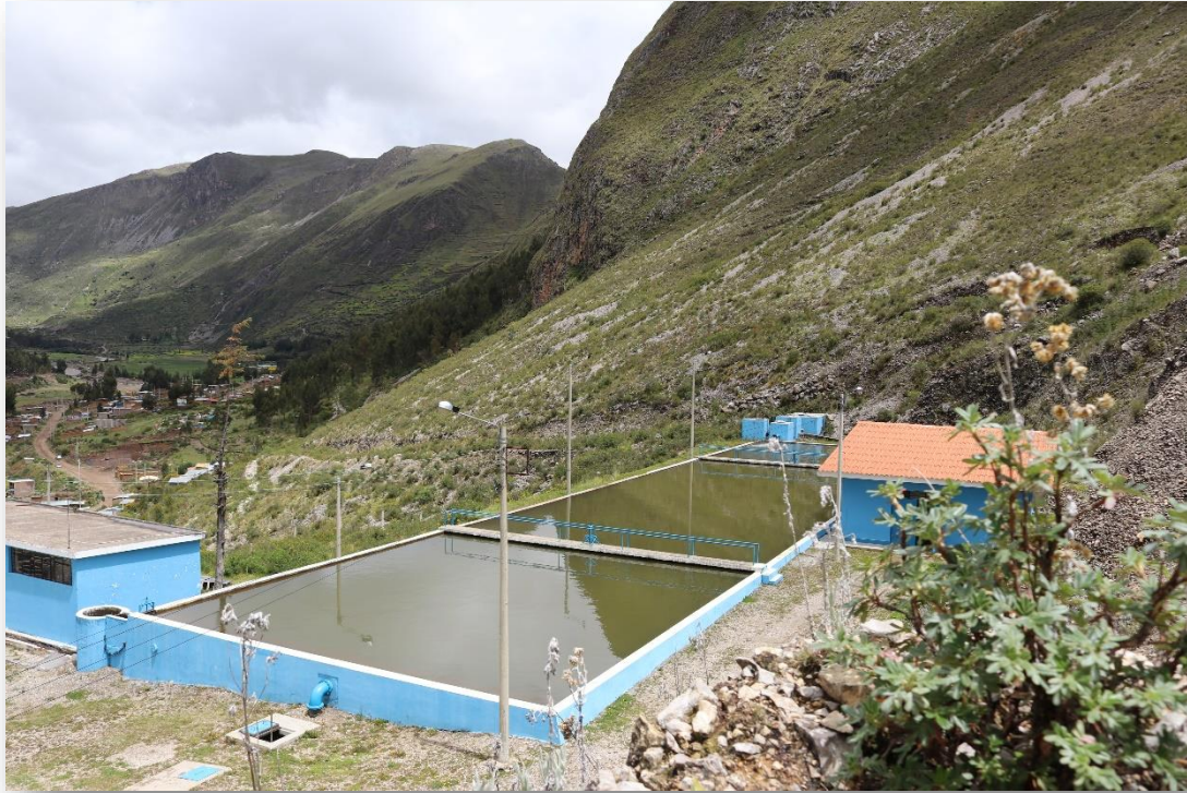
Planta de Tratamiento de Agua Millpo
