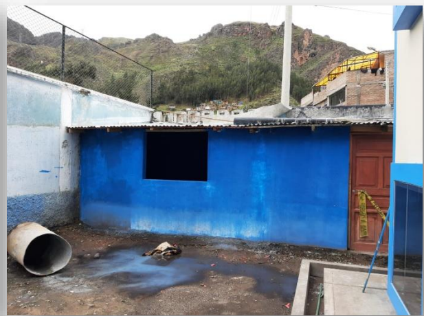
REPOSICIÓN DE CASETA DE LA I.E. MICAELA BASTIDAS AFECTADO EN LA INSTALACIÓN DE LA TUBERÍA
