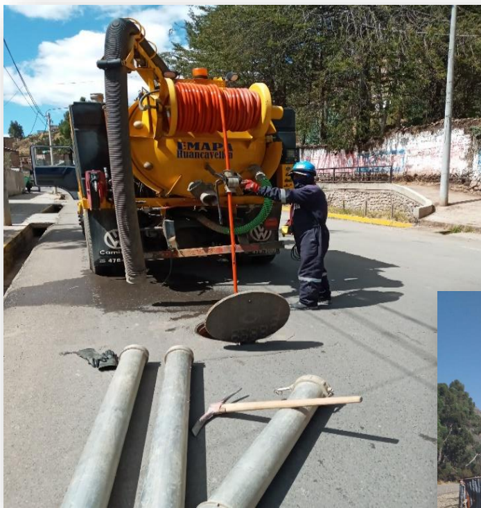
Mantenimiento de Colectores en Av. Los Incas
