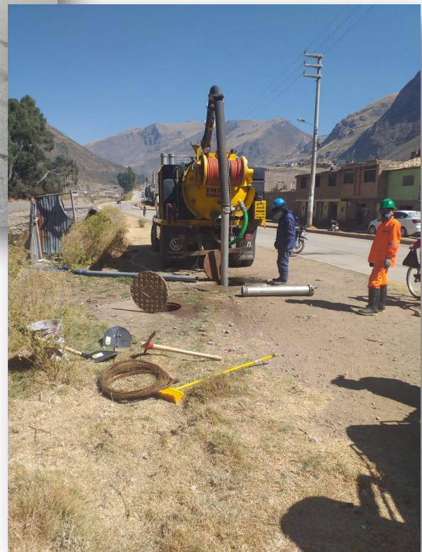
Mantenimiento de Colectores en Callqui Chico
