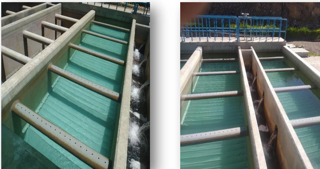
LONAS DE VINILO RENOVADO EN DECANTADORES PTAP MILLPO
