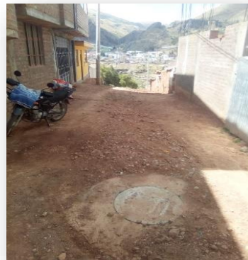
VISTA DE BUZON DE ARRANQUE CULMINADO
