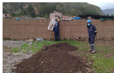
Identificación de las Nuevas redes de agua potable y alcantarillado por parte de la EPS EMAPA HUANCAVELICA en nuevas conexiones domiciliarias
