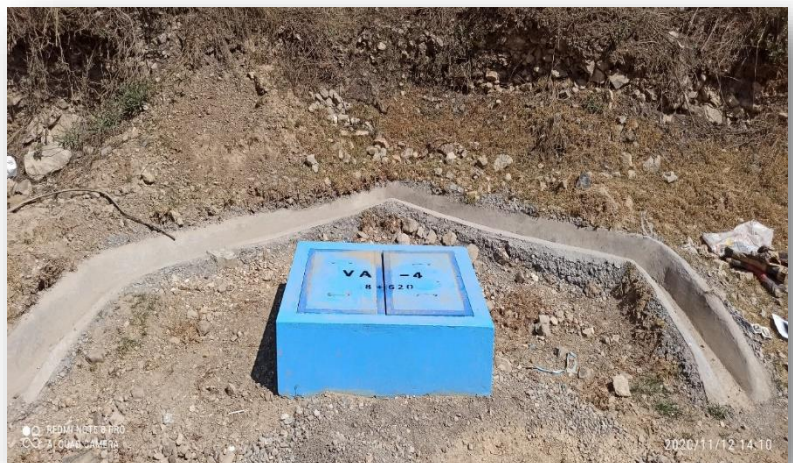
Cámaras terminadas en Línea de Conducción Millpo
