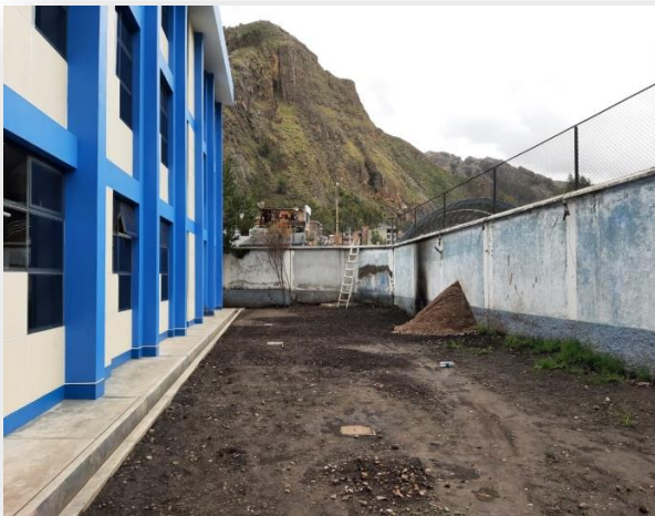
REPOSICION DE CERCO PERIMÉTRICO
