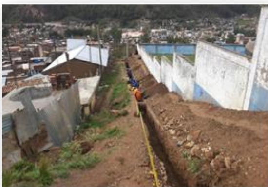
INSTALACIÓN DE RED DE TUBERÍA EN PSJE. QUINTA BOLIVIANA
