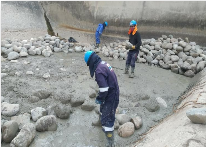
MANTENIMIENTO DE CAPTACION PUNCO
