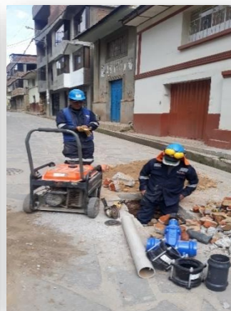
RENOVACION DE 92 VALVULAS DE 90mm, 110mm, 250mm,315mm EN LOS 10 SECTORES
