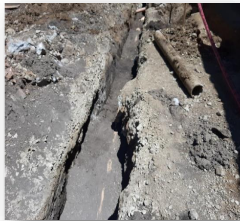
INSTALACIÓN DE TUBERÍA DE 315 MM CAMA DE ARENA
