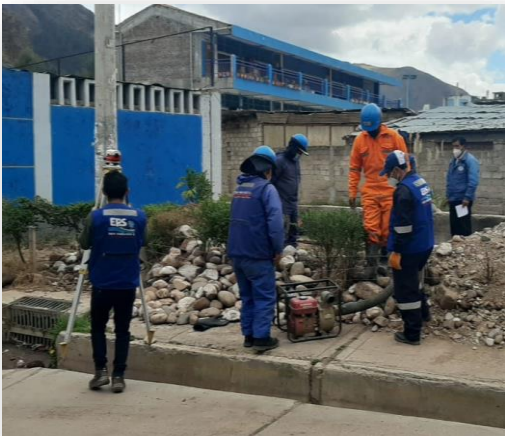
CONSTRUCCIÓN DE BUZÓN EN EL JR. LIRCAY
