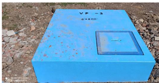
Identificación de las cámaras de Purga en las Líneas de Conducción Existente
