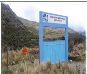
CONSTRUCCION DEL PORTON DE INGRESO
