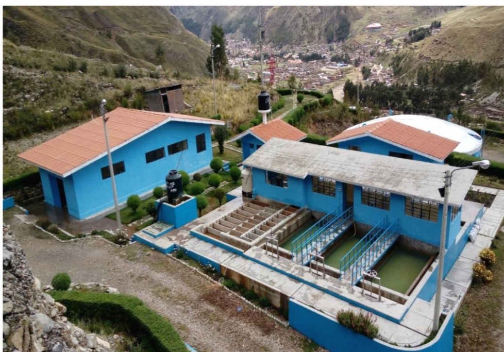
Planta de Tratamiento de Agua Potable Ichu Volumen Producido 1'231,864.75
