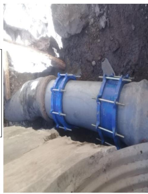
REPARACIÓN DE TUBERÍA DE LA RED DE CONDUCCIÓN ICHU DE 355 MM DAÑADO POR PROVIAS
