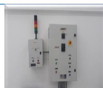
INSTALACION DE TABLERO DE CONTROL Y DE FUERZA
