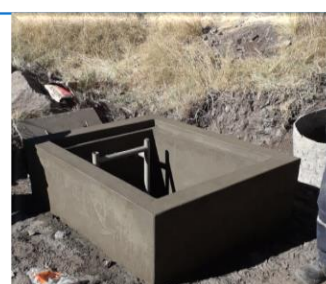
TARRAJEO DE CAMARAS DE VALVULAS EN LINEA DE CODUCCION ICHU
