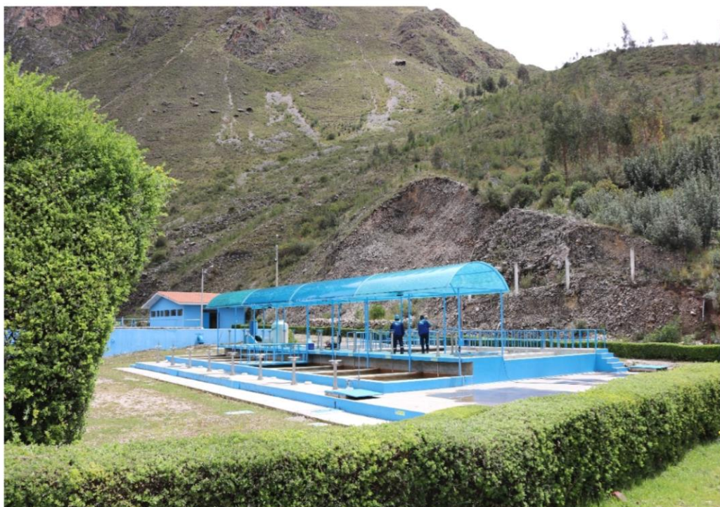
Planta de Tratamiento de Agua Potable Millpo Volumen Producido 2'558,673.50 M3.
