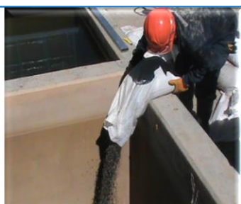
CAMBIO DE MATERIAL DE FILTRO EN LA PTAP MILLPO
