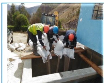
CAMBIO MATERIAL FILTRANTE EN LA PTAP ICHU
