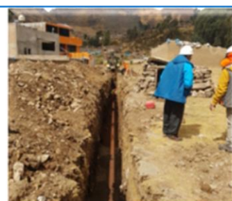
INSTALACION DE TUBERIAS DE ALCANTARILLADO
