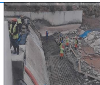
REFORZAMIENTO DEL COLCHON DISIPADOR
