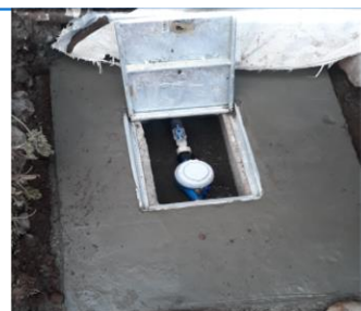
INSTALACION DE MEDIDORES DE AGUA
