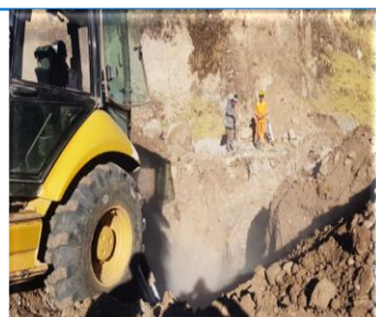
EXCAVACION PARA LA RED DE ALCANTARILLADO
