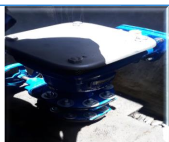
RENOVACION DE VALVULAS DE AIRE
