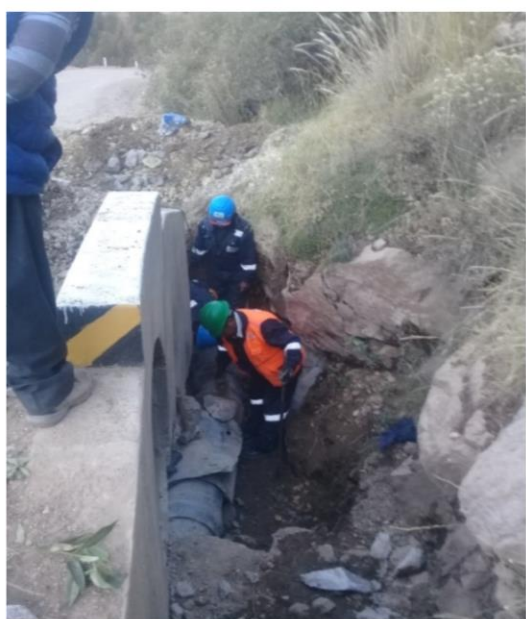
REPARACIÓN DE TUBERÍA DE LA RED DE CONDUCCIÓN ICHU DE 355 MM DAÑADO POR PROVIAS
