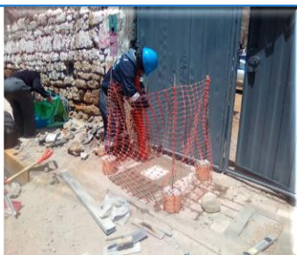
INSTALACION Y RENOVACION DE CAJAS DE F°G°
