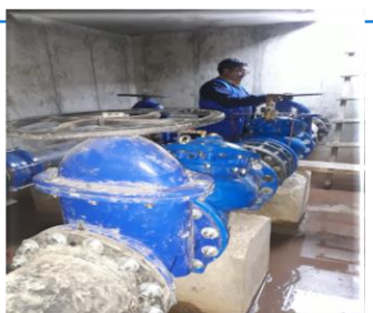
RENOVACION DE VALVULAS EN CAMARA DE VALVULAS
