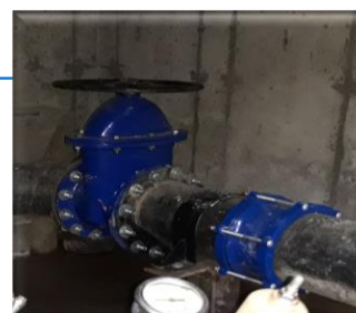
RENOVACION DE VALVULAS TIPO COMPUERTA
